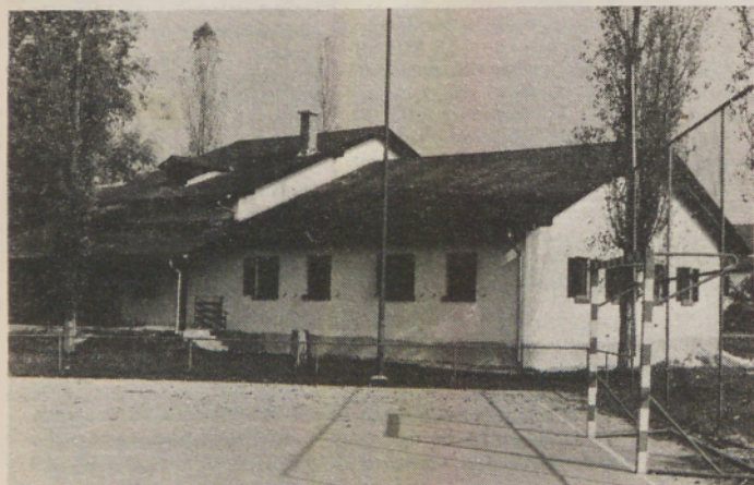
Vaško-gasilski dom z novim prizidkom v Murskih Črncih.
