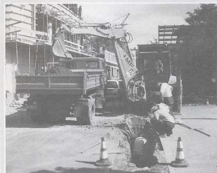
POLAGANJE KABLOV ZA PLIN JE MESTO SPET MALCE RAZRILLO, toda nove asvaltna zaplate so kaj kmalu nadomestile izkopano, tako, da kaže pohvaliti izvajalce del, investitorje pa spomniti na načrtovanje sočasnih posegov v našem neposrednem okolju.
