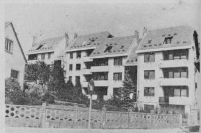
Največ stanovanj je zgradila tovarna sladkorna, okoli 100.
