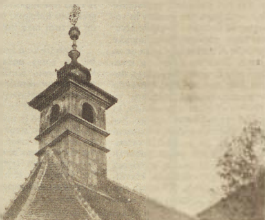
Zvonik grajske kapele v Soboti zvonov nima več, lukanje za vrvi in odprtine za zvonce pa pričajo, da je nekoč tu zvonilo.
