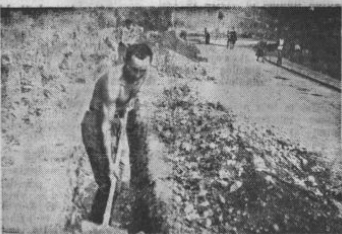
Gradnja ormškega vodovoda: iz kop proti koledvoru
