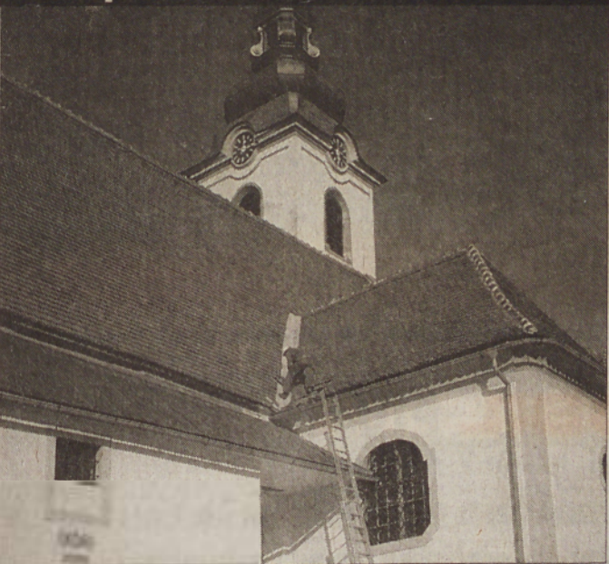
Vzdrževalna dela na strehi cerkve sv. Ruperta v Voličini. Za takšno opravilo je potrebna izjemna previdnost. Foto: F. Š.
