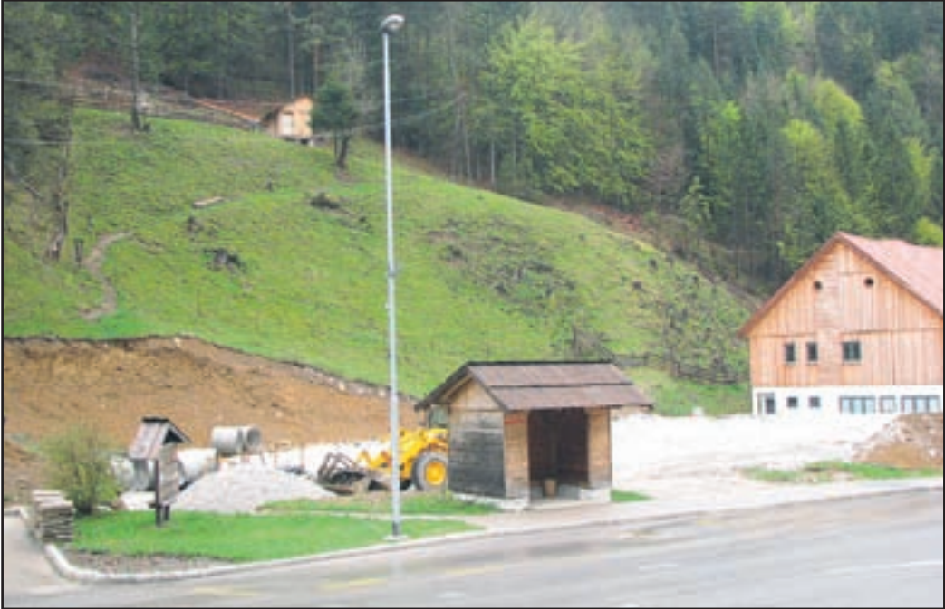
Vs redišču vasi Solčava se žed ogaja: polkrožnega objekta Rinka ni več, k malu bodo začeli graditi nov objekt, ki bo elikop rispeval ktr ajnostnemur azvojuc elotnega Solčavskega.
