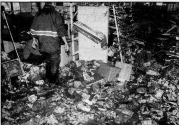
V središču udara podivjane vode je bila tudi poslovno - stanovanjska stavba, zlasti prostori TUŠ-a, katerih notranjost je nudila grozljiv prizor.
