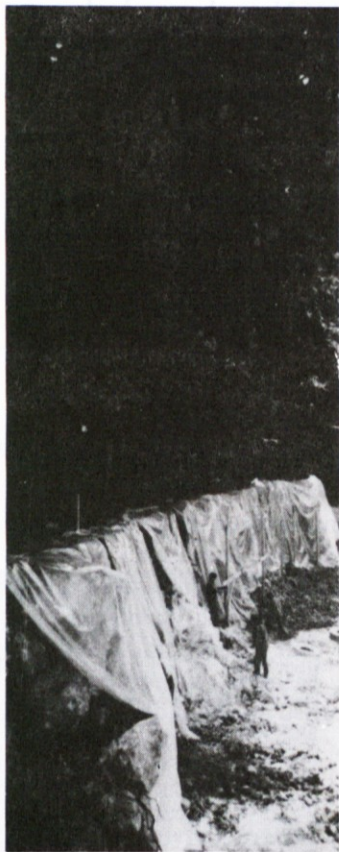
Izkop gradbene jame za »Kare L«, Ogrožen je bil koreninski sistem kostanjev, 1991, foto: Mitja Simič
