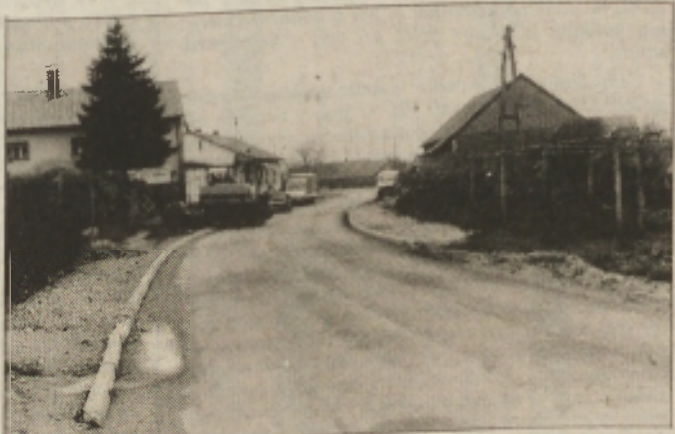
Cesta skozi Stročjo vas je naposled le obnovljena in asfaltirana. Nekaj del na odseku Ljutomer-Stročja vas pa je ostalo še za prihodnje leto.
