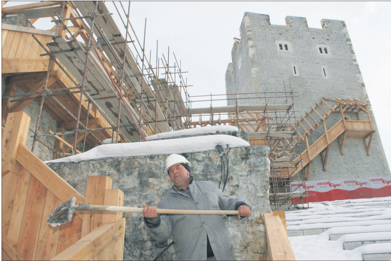
Lani so se obnovitvena dela začela še na Friderikovem stolpu.
