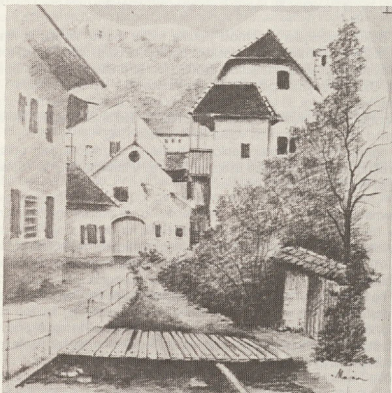
Stavbna dediščina v Tržiču (risba M. Majer)
