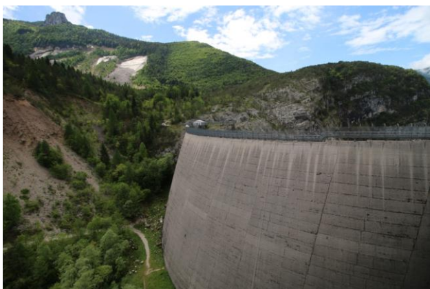
Slika 26: Pregrada je ostala skoraj popolnoma nepoškodovana.
