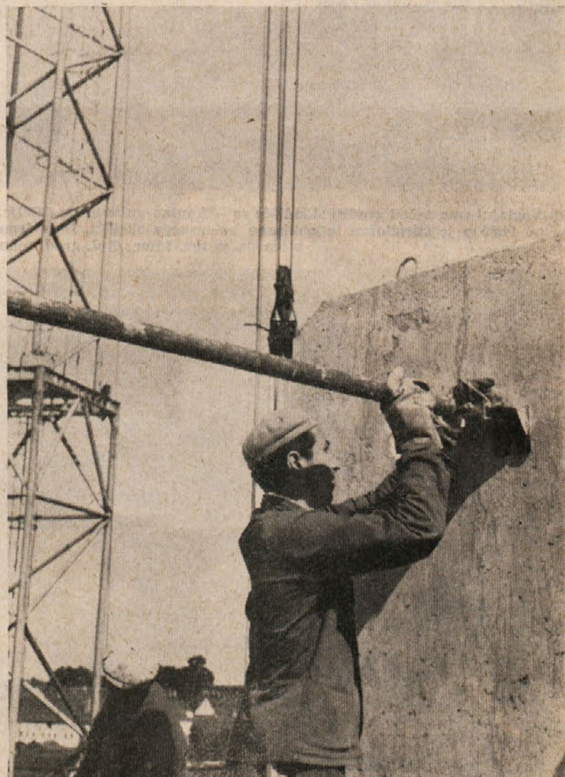
Namesto lesenih konduktorjev, kakršne uporabljamo pri naši montaži si Poljaki pomagajo s cevnimi oporami, ki so trajnejši, enostavnejši in cenejši. Način montaže je drugačen od našega.
