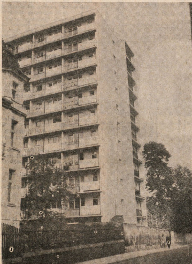
Slika prikazuje montažno stanovanjsko stolpnico. Elementi so izdelani v tovarni in nato prepeljali na gradbišče. Težki so od 0,5 do 4,5 t, kar zahteva težke dvigalne stroje.
