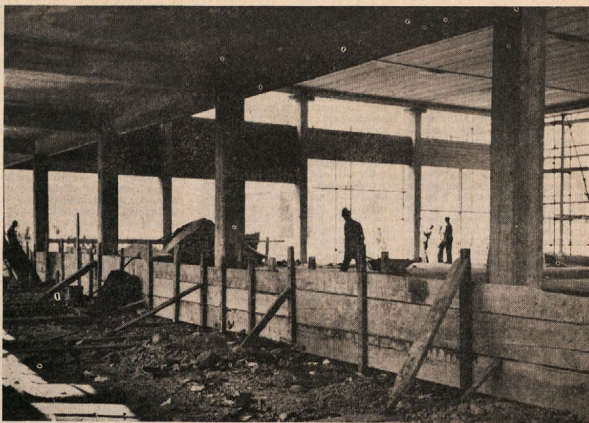
Naši operativci so bili tokrat hitrejši od naših fotografov. Objekt »Sinalco« smo zgradili in oddali investitorju v 100 delovnih dnevih. Slika prikazuje delo v notranjosti tega objekta. Vodja gradbišča je bil tov. Maks Gajšek, dipl. grad. tehnik.
