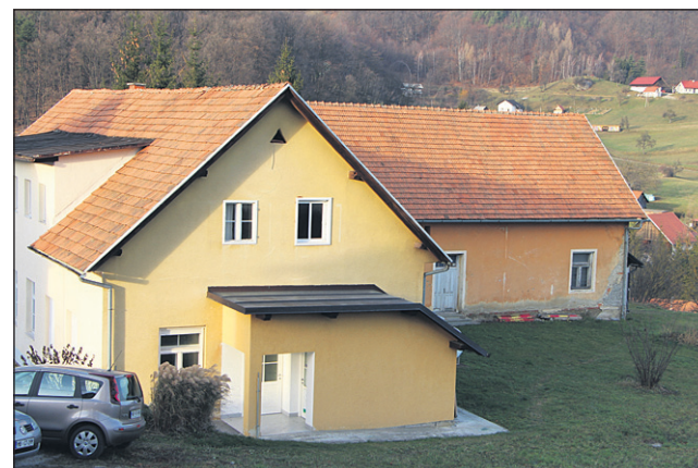
Stara dvorana je dotrajana, če bo občina uspešna na razpisu za pridobivanje sredstev, bodo na tem mestu spomladi najprej potekala rušitvena dela, nato bo pričela rasti nova večnamenska dvorana.
