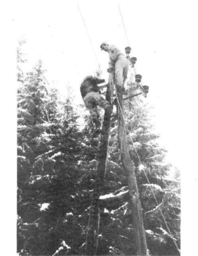
Delavca sevniske enote Elektra Bojan Androjna in Franc Pintar med popravilom daljnovoda Krmelj-Šentjanž. (Foto: Franci Pavkovič)
