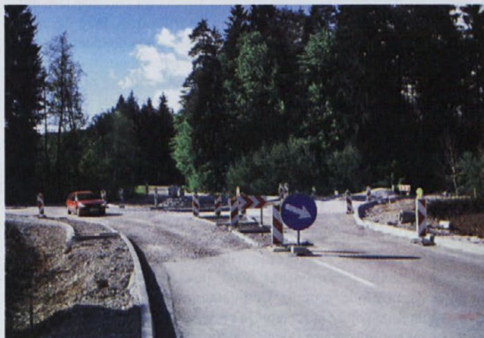
Krožišče na lokalni cesti Spodnje Pirniče - Smlednik.
