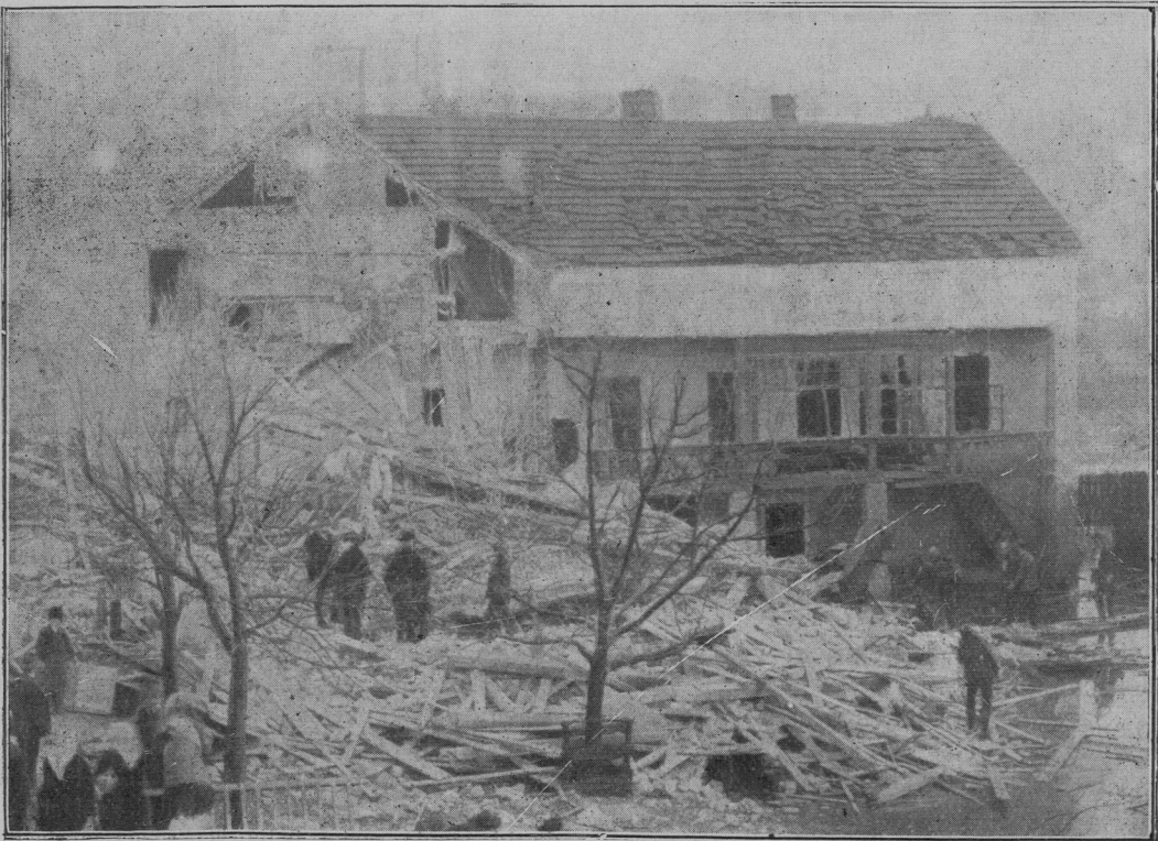
Grozna nesreča v Brežicah. Porušena hiša Volčanškova.
