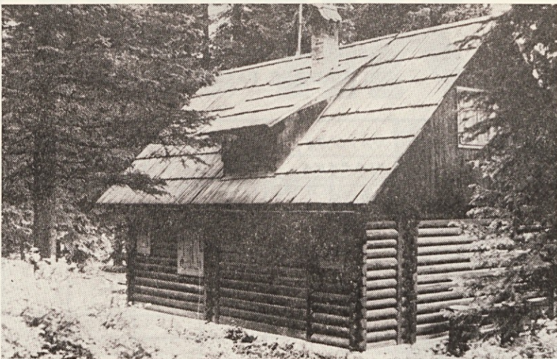
V »kajži« na Pokljuki bo potrebno še v tem letu opraviti sanacijska dela
