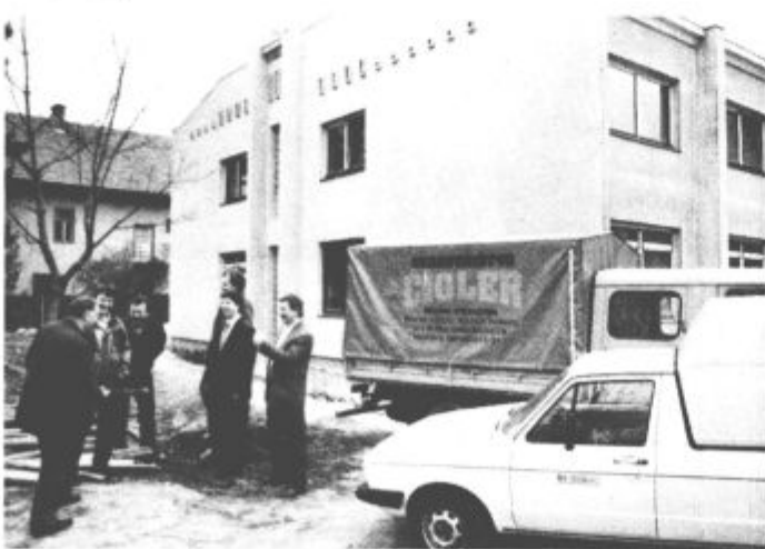
Na gradbišču prizidka Kulturnega doma smo se prejšnji teden srečali s tistimi, od katerih je odvisno, ali bo objekt končan do predvidenega roka
