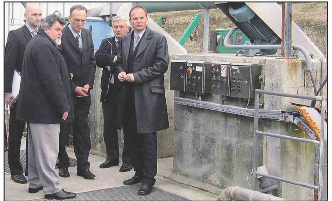
Ob ogledu obstoječe centralne čistilne naprave
