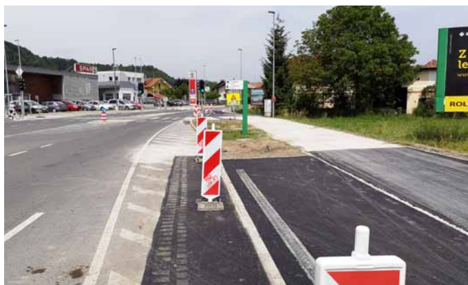
Tudi pripravljana dela za izdelavo priključkov za novi dom zaščite in reševanja na križišču Ljubljanske in Mengeške ceste so v zadnji fazi.
