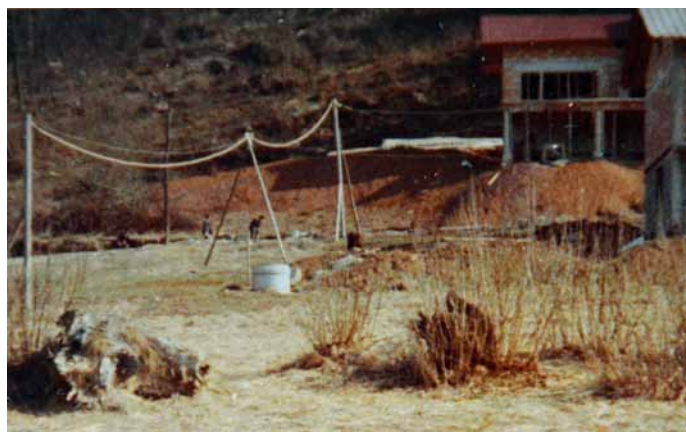
Sporni jašek je bil postavljen že sredi sedemdesetih let prejšnjega stoletja.
