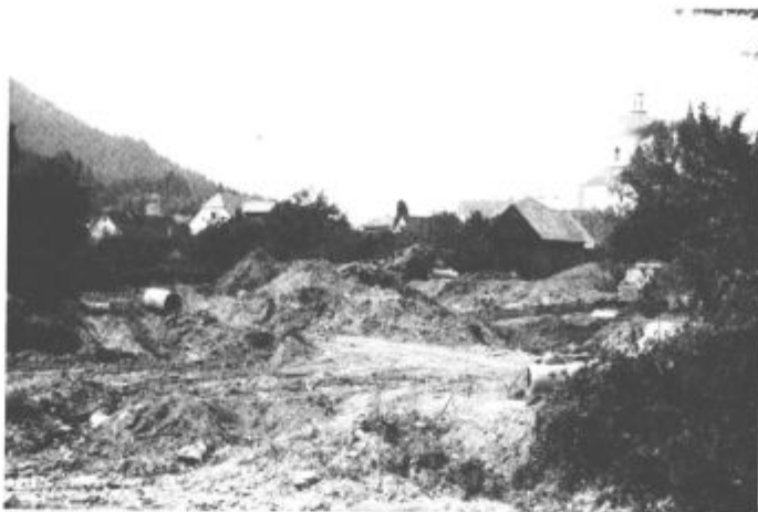
Primarni vod kanalizacije bo kmalu zgrajen, čakajo pa že nove naloge
