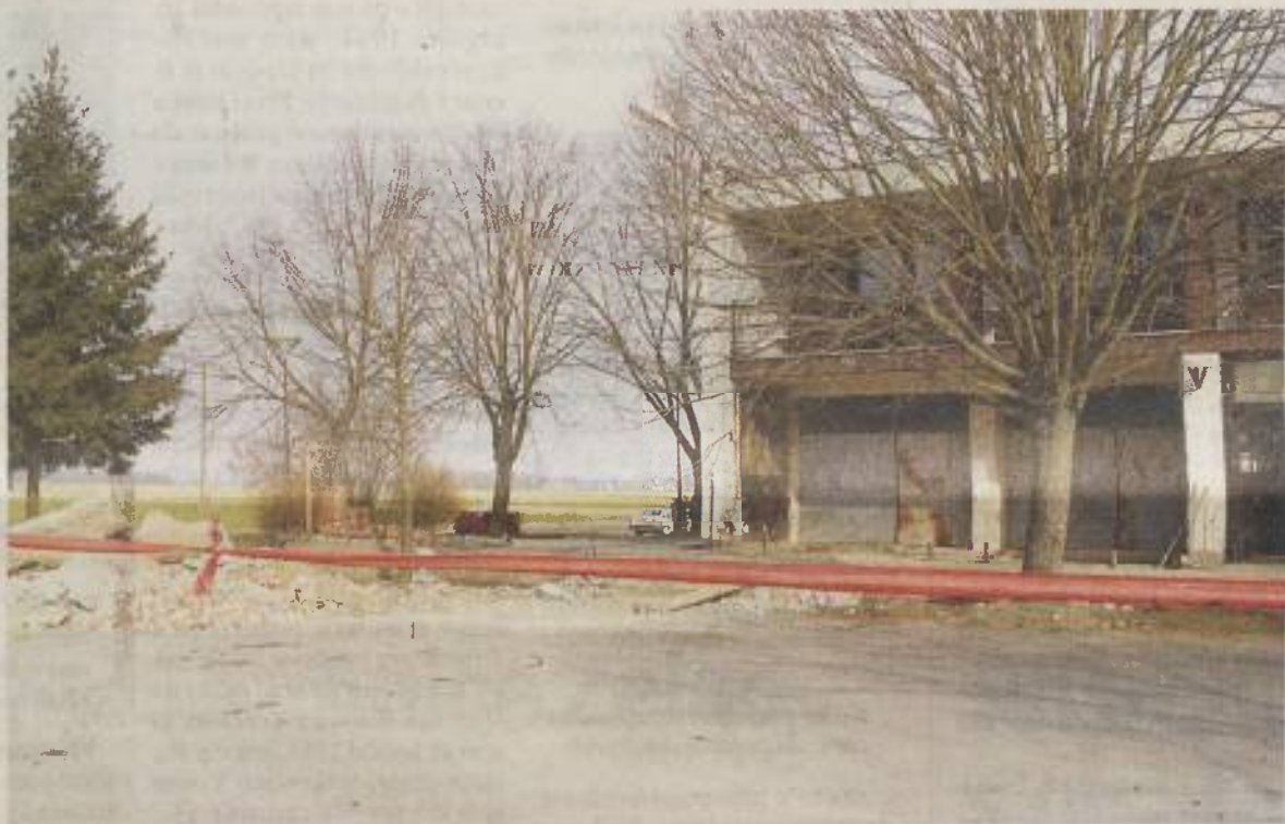
Že nekaj dni potekajo na objektu Čarde pred Martjanci velika gradbena dela; obnovili bodo celotno zgradbo, sobe in teraso.
