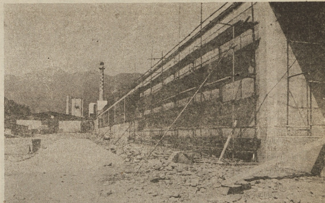
Alples Železniki — nova proizvodna hala.
