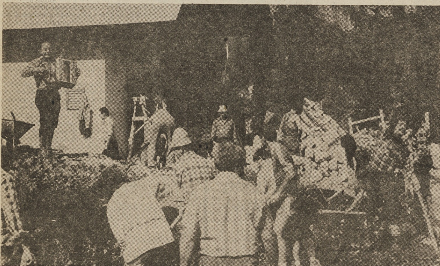
Kljub utrujenosti so naši vrli planinci na povratku s Triglava poprijeli za lopate in krampe ter izkopali jamo za vodni rezervoar pri koči na planini Jezero. Seveda je bilo ob poskočnih vizah delo veliko lažje.
