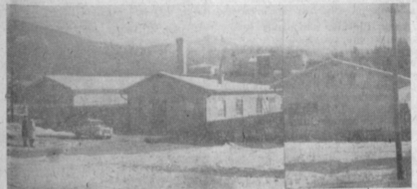
Nova proizvodna hala, ki je zgrajena iz lastnih sredstev
