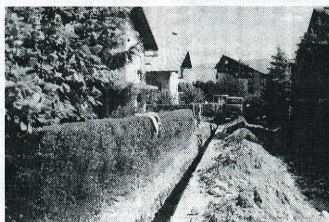
GRADNJA PLINOVODA NA DUPLICI - do konca septembra bodo v KS Duplica zgradili 10 km plinovodnega omrežja in 300 priključkov. Do srede julija so položili že 100 m plinskih cevi.
