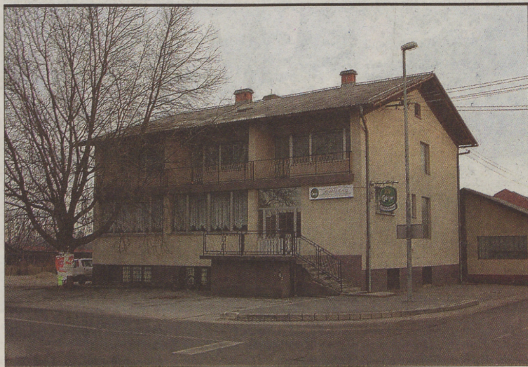
Pogled na nekdanje dobro obiskano Sabovo, pozneje Jerebičovo gostišče na Gornji Bistrici, ki pa vedno bolj propada.
