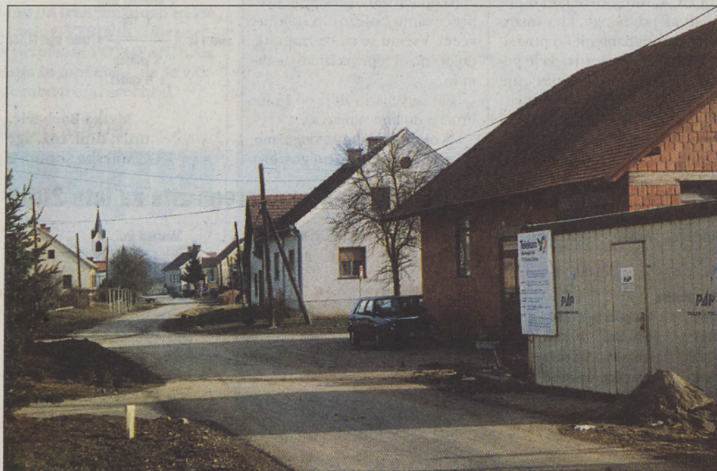
V Bučecovcih te dni polagajo zemeljske kable za telefon in vaško televizijo, vaščani pa pogrešajo še cestno razsvetljavo. Foto: F. Š.
