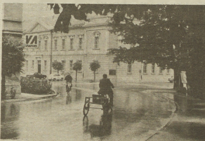
SODIŠČE V LENDAVI — Lendavski gradbinci ne grade le novih objektov, ampak obnavljajo tudi stare. Taka dela so opravljali na Madžarskem, v Lošnju ... pa tudi v Lendavi. Pred kratkim so lepo obnovili stavbo sodišča. (Slika). Foto: Š. S.
