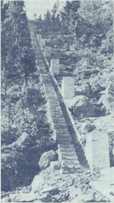
Tlačni cevovod, ki ga bodo montirali strokovnjaki iz Metalne (Foto: S. Štokelj)
