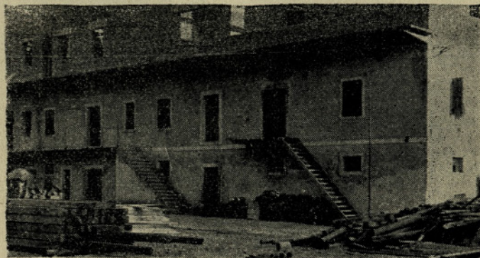
Nova, letos za prvo uporabo zgrajena sušilnica za hmelj 2 x 16 m 2 — v prizidku bosta še 2 x 16 m 2 — v pritličju pa so že skladišča in kovaška delavnica.
