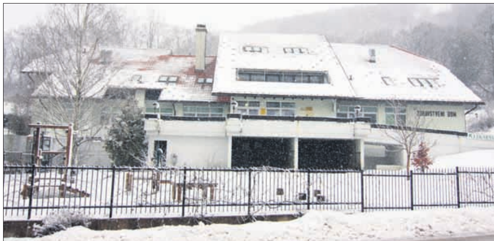
Vrtec v Podčetrtku, ki je dolga leta brez uporabnega dovoljenja, domuje v zgornjih prostorih zdravstvene postaje. V njem je že prišlo do požara.
