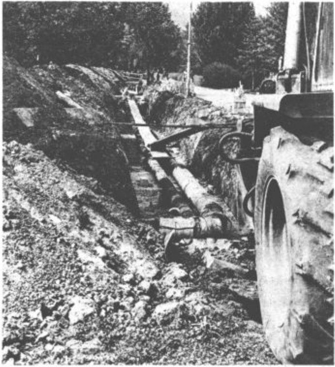
Velenjski Toplovod se je pri sanaciji našega toplovodnega omrežja tako izpopolnil, da bo prevzel dela tudi pri popravilu izolacije na toplovodnem omrežju v Celju.
