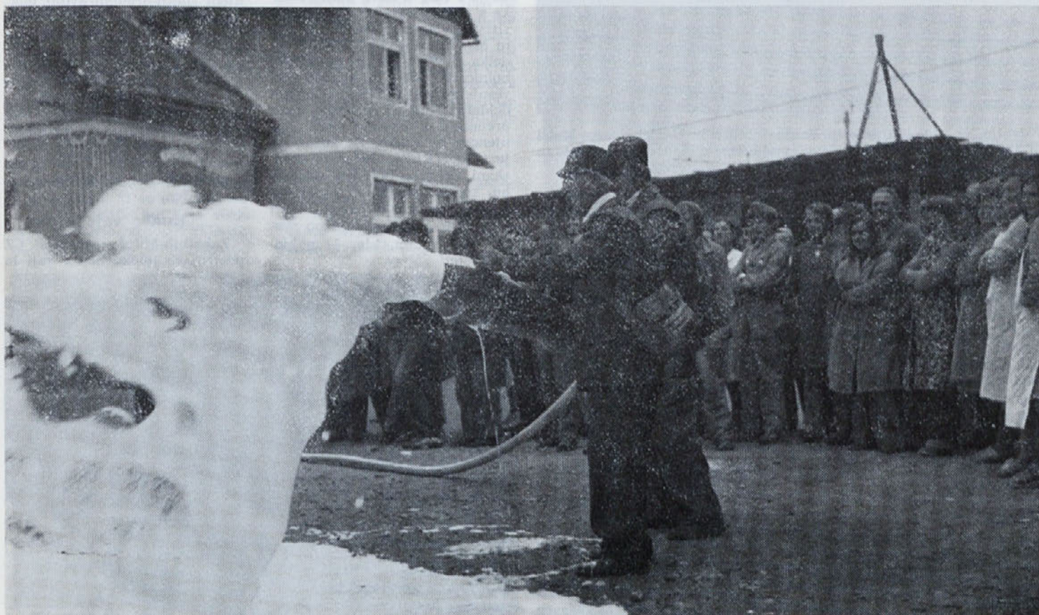
Oddelek gasilskega voda CZ DO Jelovica v napadu s peno. Resen pristop k vaji opazujejo delavci proizvodnje
