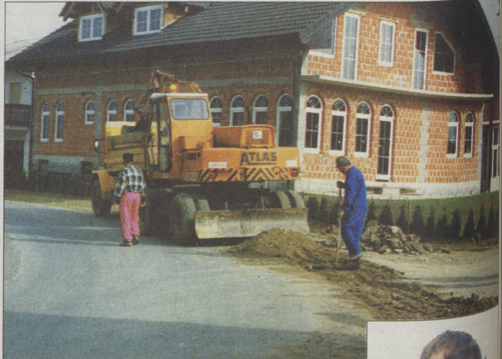
Končana kanalizacijska dela
