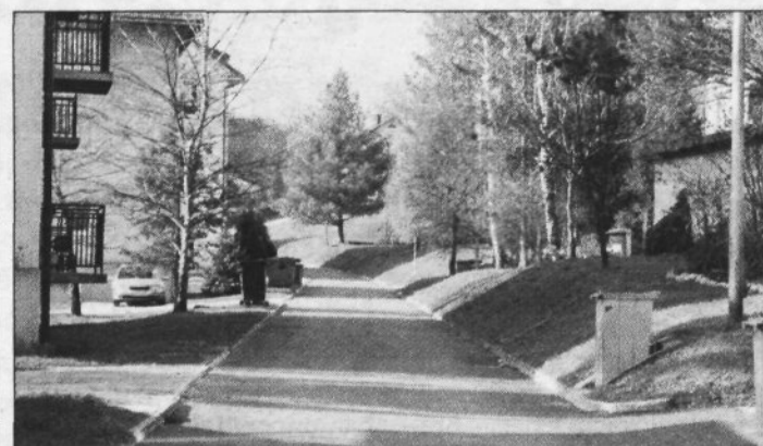
Občina Krško je v minulih tednih zaključila z modernizacijo Elektrarniške ulice v Brestanici, kjer je obstoječi asfalt zamenjala z novim in na novo asfaltirala 500 m cestišča.
