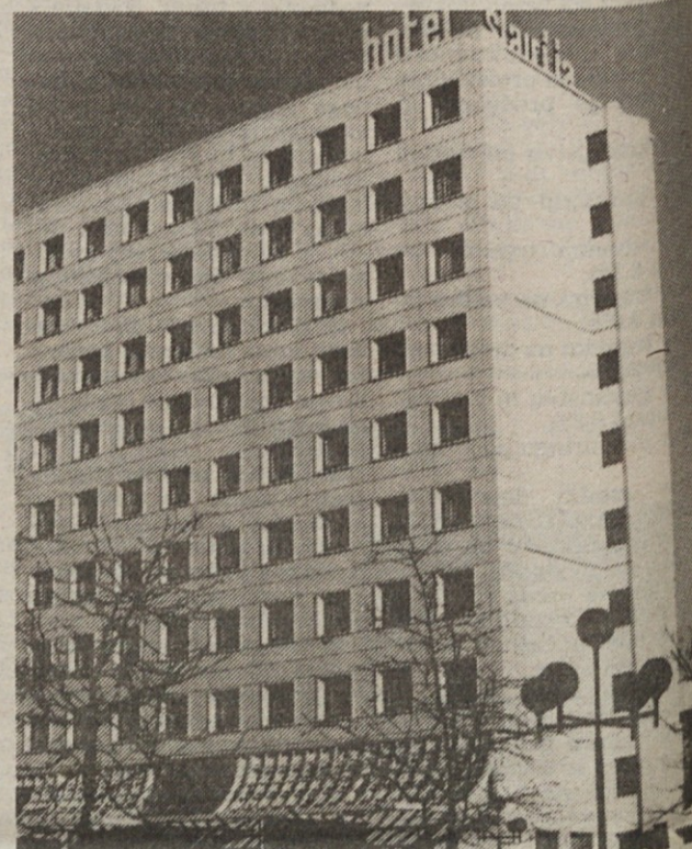
Kot nevesta v beli obleki, prava lepota je sedaj mariborska Slavija. V februarju bodo pokrili še nadstrešek pred glavnim vhodom, potem pa bo vse nared, je povedal direktor hotela Boris Šverko.
