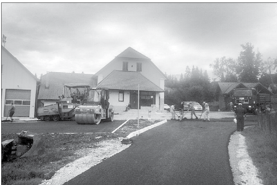
VOC Celje je z asfaltiranjem zaključil zunanjo ureditev okolice novega radmirskega gasilskega doma, odseka ceste proti radmirski cerkvi in nove povezovalne ceste, ki se priključuje na regionalno.
