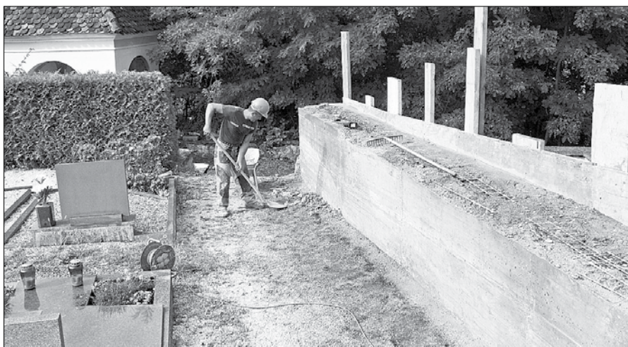
Obnovitvena dela so opravljena tudi zaradi varnosti ljudi, ki obiskujejo pokopališče ali se zadržujejo na tem območju. (Foto: Marija Lebar)
