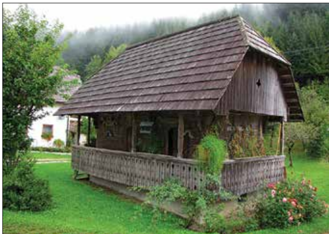
Skrbno vzdrževana in lepo ocvetličena Mavričeva kašča
