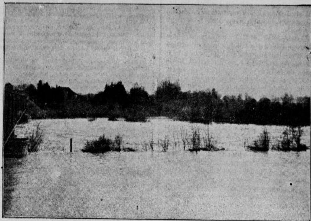
Pogled na Savo z železniškega mostu pri Črnučah. Voda je prestopila visoke bregove in zalila vso okolico.
