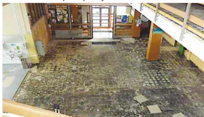
Obnova notranjosti šole leta 2011 (foto: arhiv OŠ Grad)
