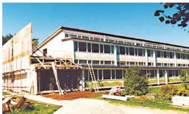
Gradnja vrtca pri OŠ Grad leta 2000 (foto: arhiv OŠ Grad)
