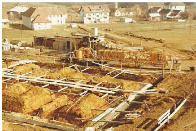
Temelji nove šole v Pörgi (foto: arhiv OŠ Grad)
