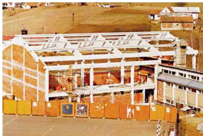
Gradnja nove telovadnice ob šoli leta 1997 (foto: arhiv OŠ Grad)
