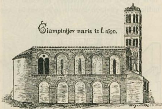
Pod. 2. Naris Ciampinijev iz l. 1690. Vidijo se zazidani spodnji loki (ki so pa v resnici širji) in okna. Prvo (odprto) okno je gotično in manjše.
