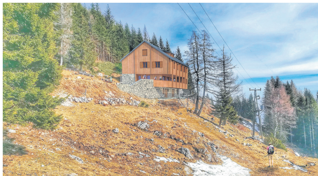
Po priporočilih Zavoda RS za varstvo narave bo nova Mozirska koč zgrajena večinoma iz kamna in lesa. Glede na to, da je del stare koč, ki je bil zgrajen iz kamna, ostal, ga bodo poskušali ohraniti. Po velikosti bo podoben prejšnjemu. Foto: PD Mozirje
