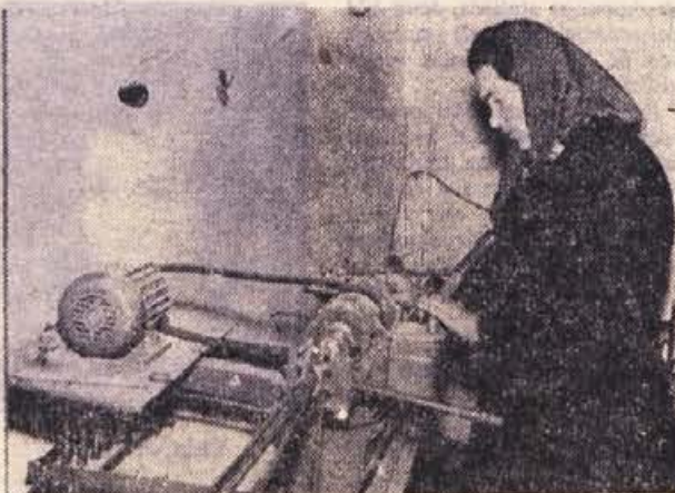
Milena Grubič obdeluje v »METALU« v Jesenicah na Dolenjskem s polirnim strojem kovinske dele električnih vtičnikov.
