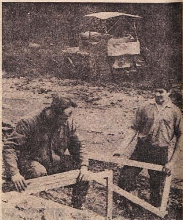
Vodna skupnost Dolenjske je začela popravljati strugo Mirne pod Tržiščem, kjer je voda že začela spodjedati cesto, ki pelje v Sevnico. Na sliki sta delavca Alojz Gričar iz Dol. Jesenice in Vinko Judež iz Gabrja, ki ugotavljata nagib nove struge, kamor bodo spuštali vodo, ko bo vsek dokončan. (Foto: M. Legan)
