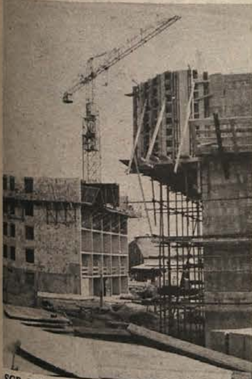
SGP Zidar iz Kočevja je pričel graditi šest nadstropnih blokov v Tesarski ulici v Kočevju. Tako bodo Kočevjarji prišli do 101 novega stanovanja. Posebnost gradnje je v povsem novem načinu uporabe jeklenih tunelnih opažev. (Foto: F. Brus)
