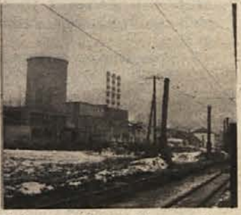
Elektrarna Brestanica po rekonstrukciji prizanaša okolju, saj bistveno manj onesnažuje zrak in vodo kot prej.
