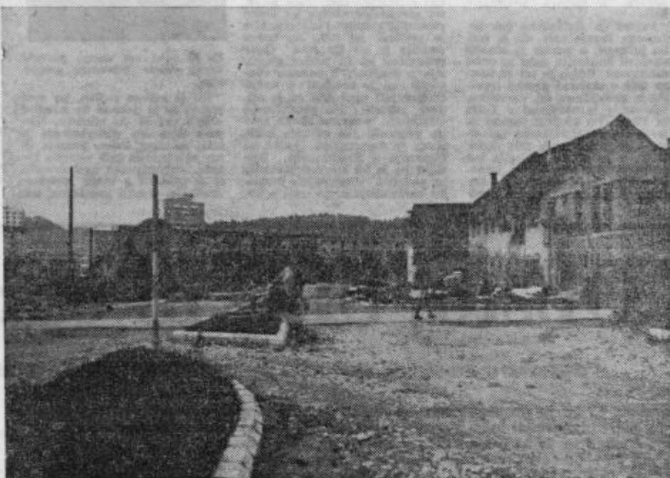
Zaradi nove ceste skozi Staro Velenje so morali porušiti več objektov, med katerimi tudi dvoje stanovanjskih poslopij. Posnetek prikazuje del modernega križišča z zelenimi pasovi in traso do porušeni objektov.
