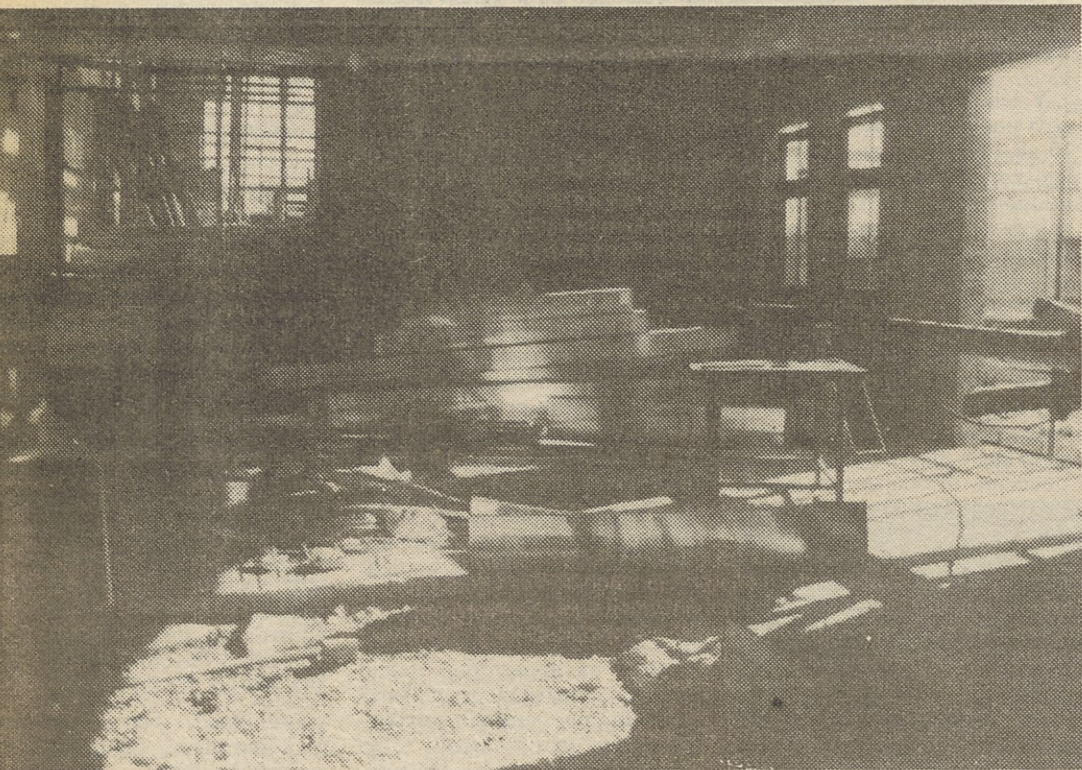
Kletna etaža v zaključni fazi montaže
