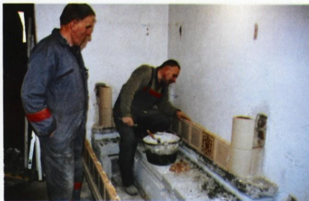
Mojster Košir postavlja kamin.
